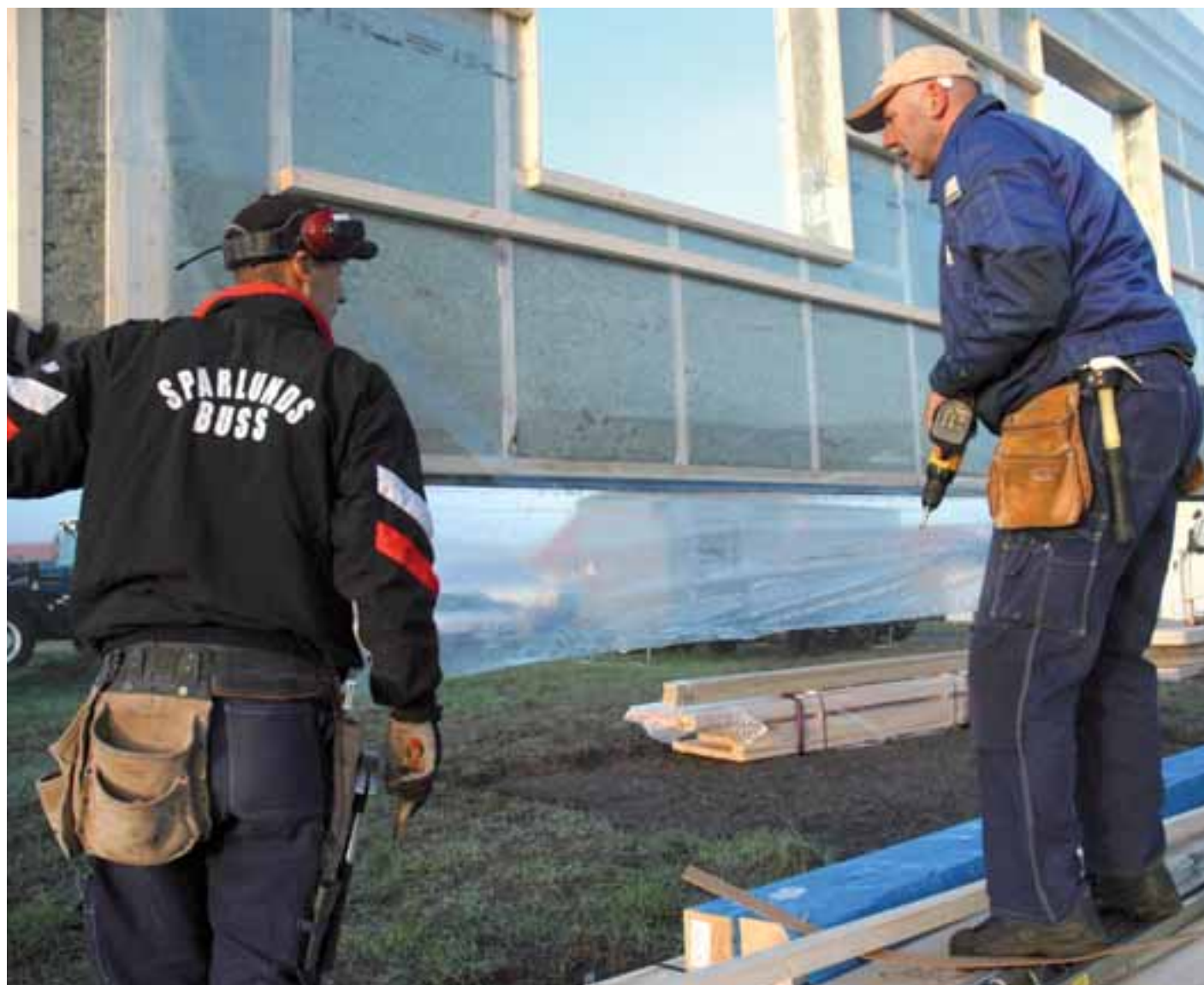
Mattias Johansson och Rolf Andreasson monterar första innerväggblocket som levererats direkt från fabriken i Värghårda.
