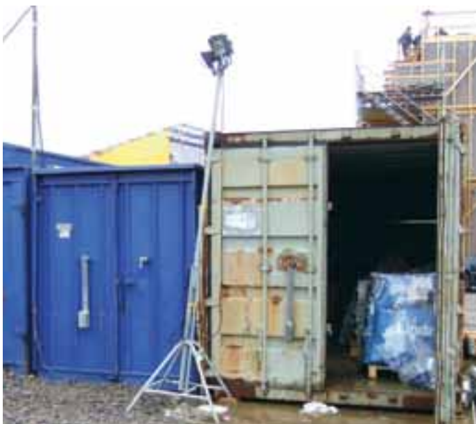
Attraktiva containers tillhörande Ottossons Bygg AB. De har brutits upp, skadats och tömts vid ett flertal tillfällen.
