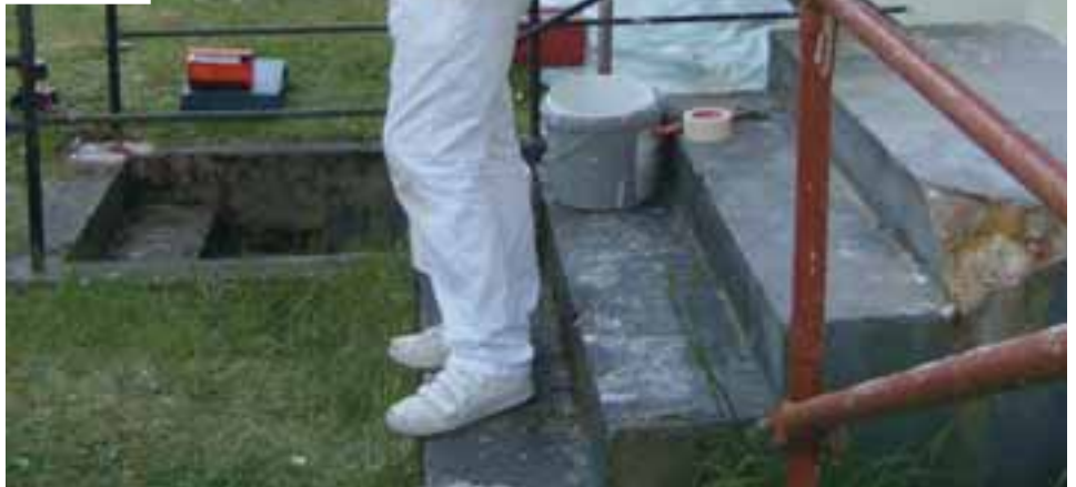
Ett stenkast från kyrkan i Södra Sandby håller Jörgen Pilz på att putsa fasaden på ett 40-tals hus. Halva fasaden återstår att återställa i nyskick. När arbetet är avslutat har han jobb minst ett år framåt.
