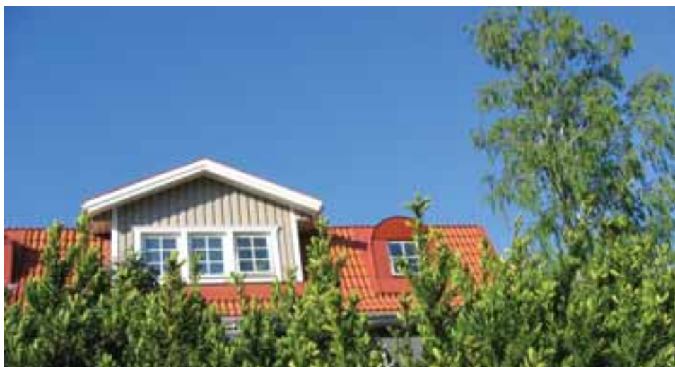
Under takarbeten upptäckte byggföretaget att takfönstren var felaktigt monterade och åtgärdade detta vilket gjorde jobbet dyrare än beräknat. Kunden protesterade – men förgäves.
